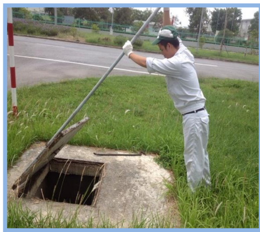
Kiểm tra cống thoát
